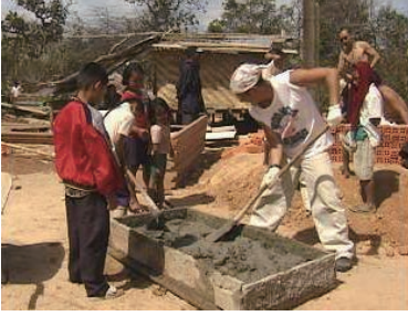
学校建設団による作業の様子
